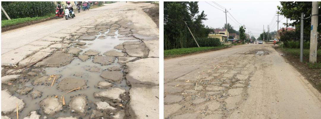
图 1-3 部分路段水泥路面受损图
