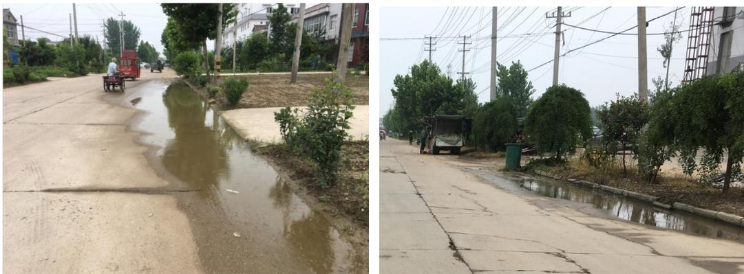
图 1-4 雨天路面积水图
